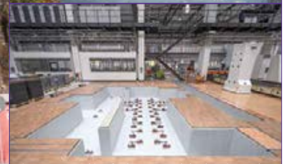
Eins von 13 Maschinenfundamenten und darüber eine Neubauhalle der Porsche Werkzeugbau GmbH in Schwarzenberg.
